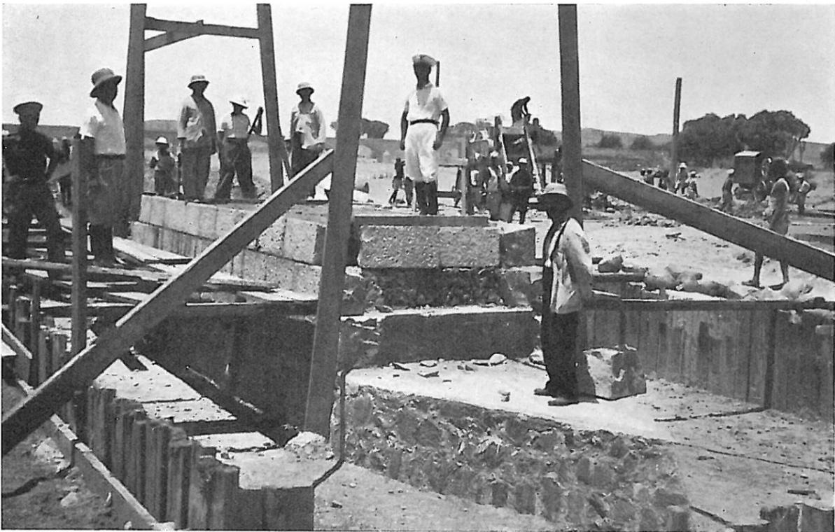
*COSTRUZIONE DI UNA SPALLA DELLO STESSO PONTE*
