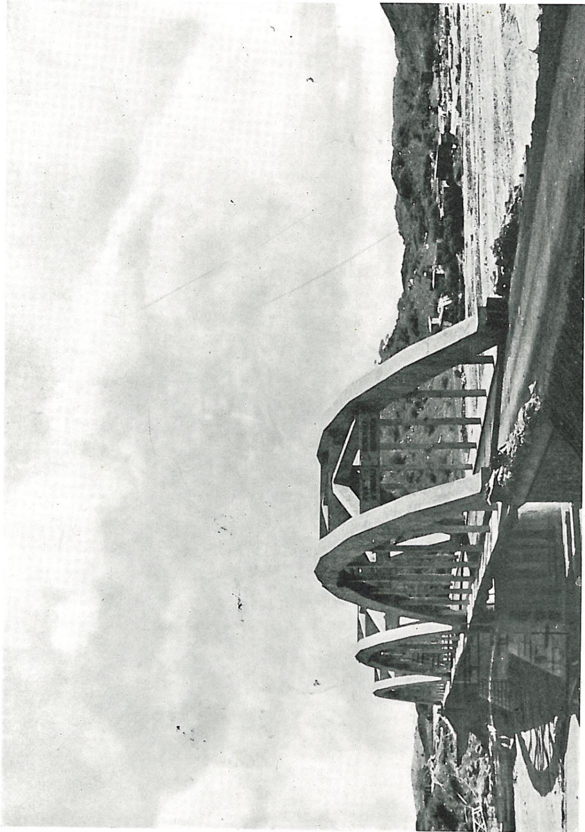
IL PONTE DI DOGALI (3 arcate in cemento armato di 44 metri di luce netta ciascuna)
