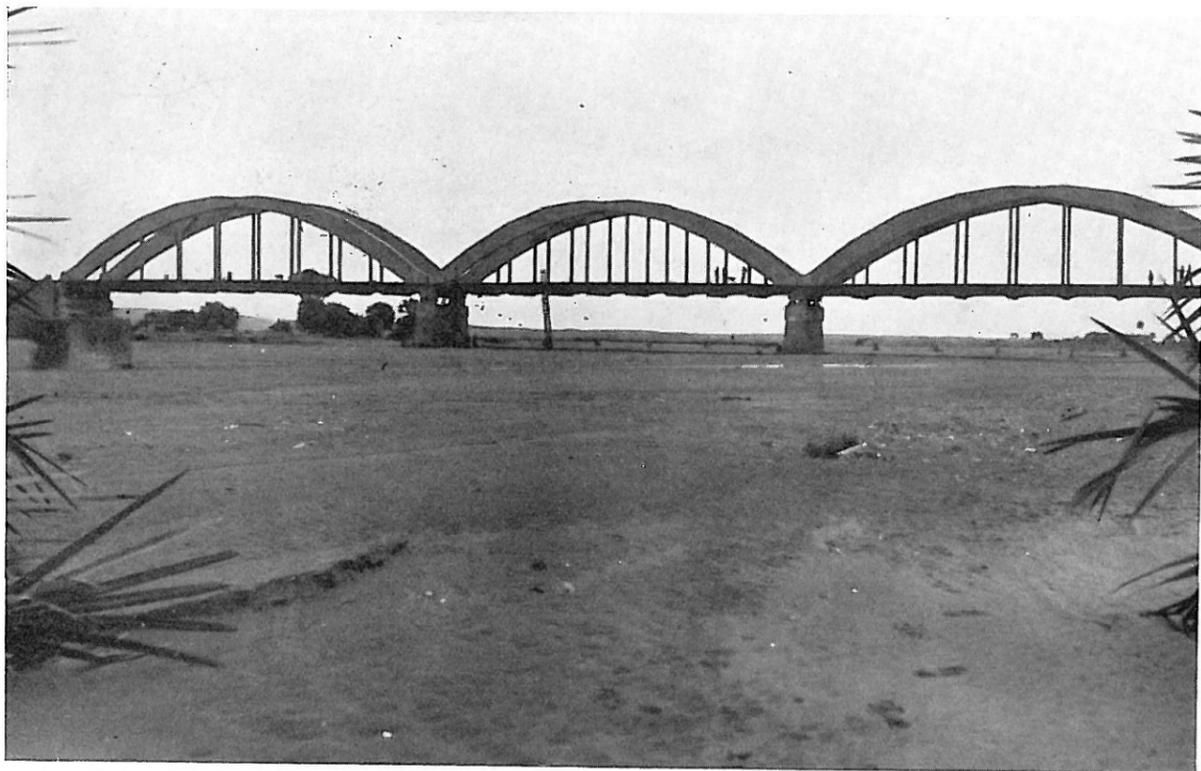
*IL PONTE IN CEMENTO ARMATO DI MONCULLO (2 arcate laterali di 44 metri ed una centrale di 38 metri di luce netta)*
