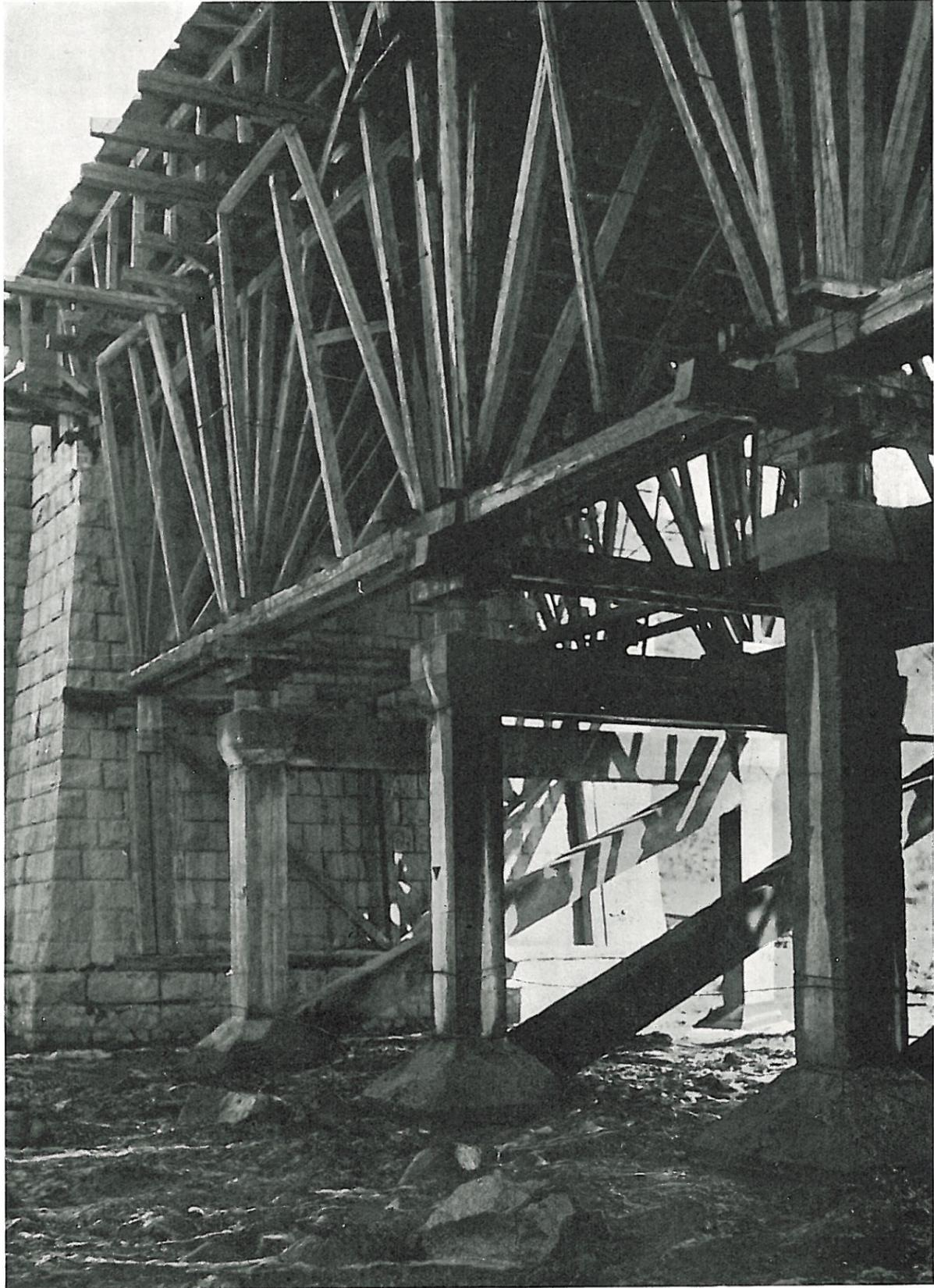
CAVALLETONI DI CEMENTO ARMATO A SOSTEGNO DELLE CENTINE PER RESISTERE ALL'IMPETO DELLE PIENE
