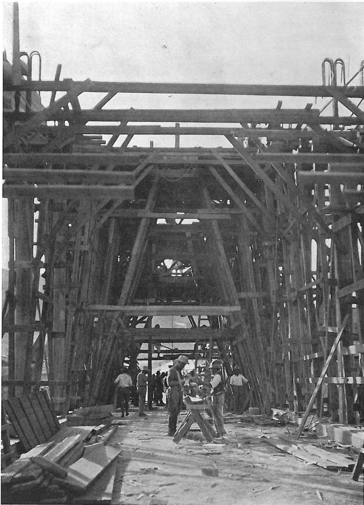
*CENTINE DI SOSTEGNO DELLE SOPRASTRUTTURE DEL PONTE*
